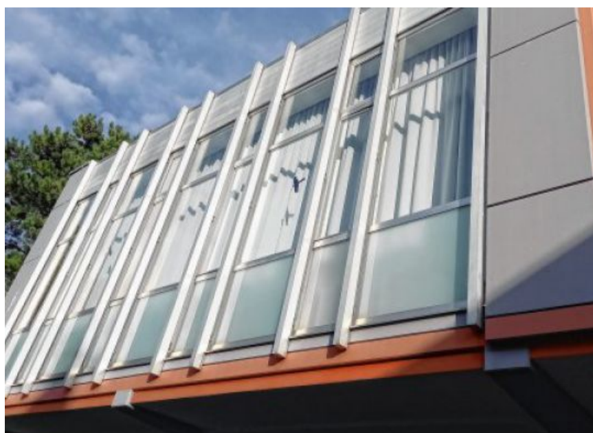
Der Sitzungssaal des Rathauses von Rielasingen-Worblingen soll einen zweiten Rettungsweg mit einer Fluchttür und einer Stahltreppe bekommen. FOTO: JACQUELINE WEISS
